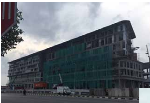
The Emporium @ Jln Tun Jugah underway
